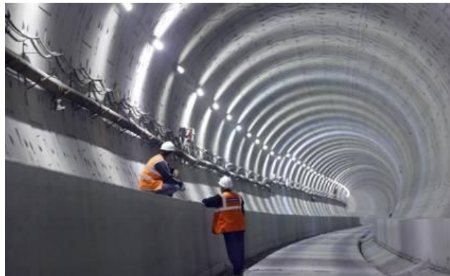
Projekt CTRL v Anglii (využití vláknobetonových segmentů)
