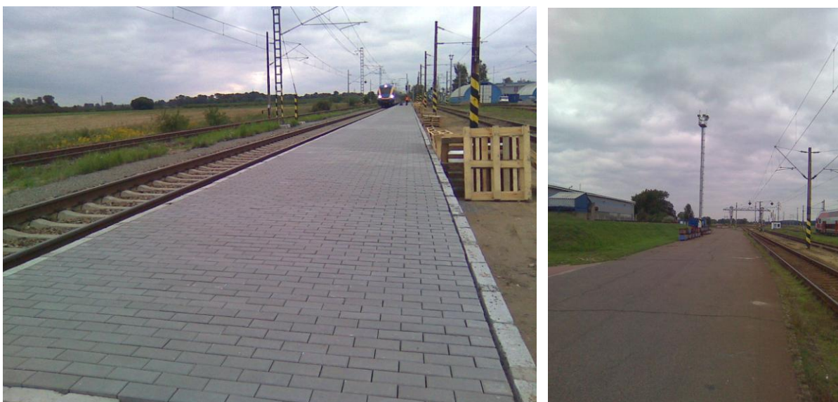
Modernizace TV na ZC VUZ Velim
