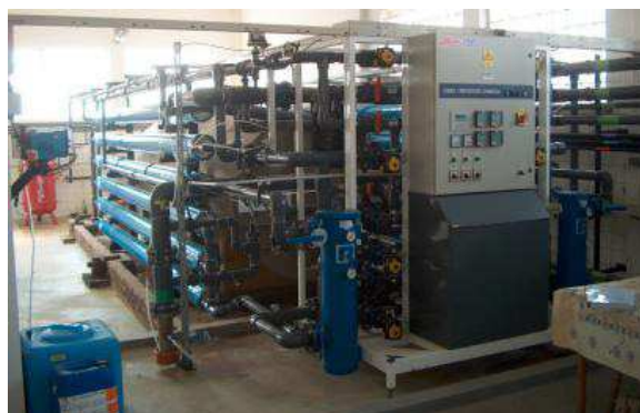
Obrázek 7: DEMI jednotka RO - WATEK s.r.o. Obrázek 8: Jednotka RO - VWS Memsep s.r.o.
