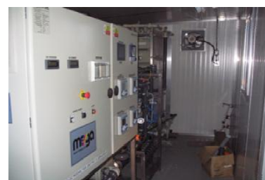
Obrázek 9: Schema a fotografie membránové technologie firmy MEGA a.s. pro úpravu technologické vody z vrtu na plyn.
